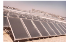
太阳能热泵热水系统
